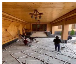
Șablonarea și pregătirea suprafețelor
