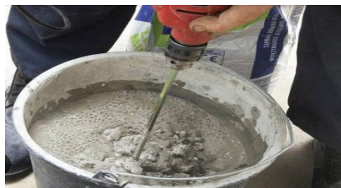
Pregătirea mecanizată a mortarului
