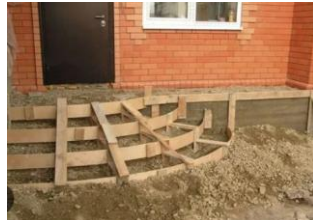
Montarea cofrajelor
