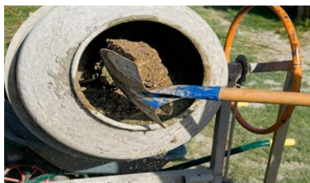
Pregătirea mecanizată a mortarului
