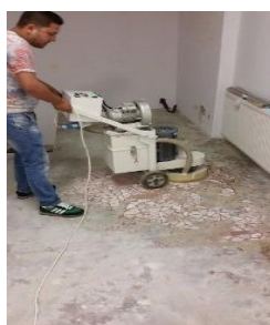
Șlefuirea uscată a mortarului cu ajutorul mașinilor mecanizate
