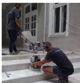
Șlefuirea uscată a mortarului cu ajutorul mașinilor mecanizate
